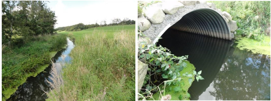
Foto 3. Tv. opstrøms Damsgårdvej. Th. rørunderføring under Damsgårdvej
