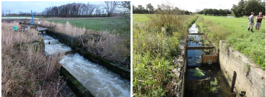
Foto 1. Opstemning/spærring (AAL-1306) ved henholdsvis stor afstrømning (fotograferet opstrøms) og lav afstrømning (fotograferet nedstrøms)
